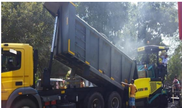
Fig No: 5 Laying
