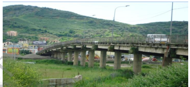
Fig. 1. General view of Vora brigde
